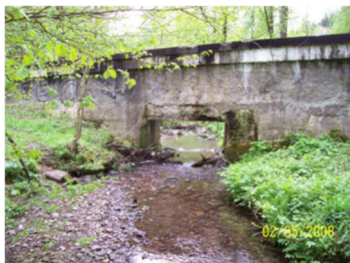
Abbildung 14: Retentionsraum Klausener Bach
